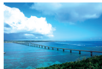
⑤宮古島市【伊良部大橋】
